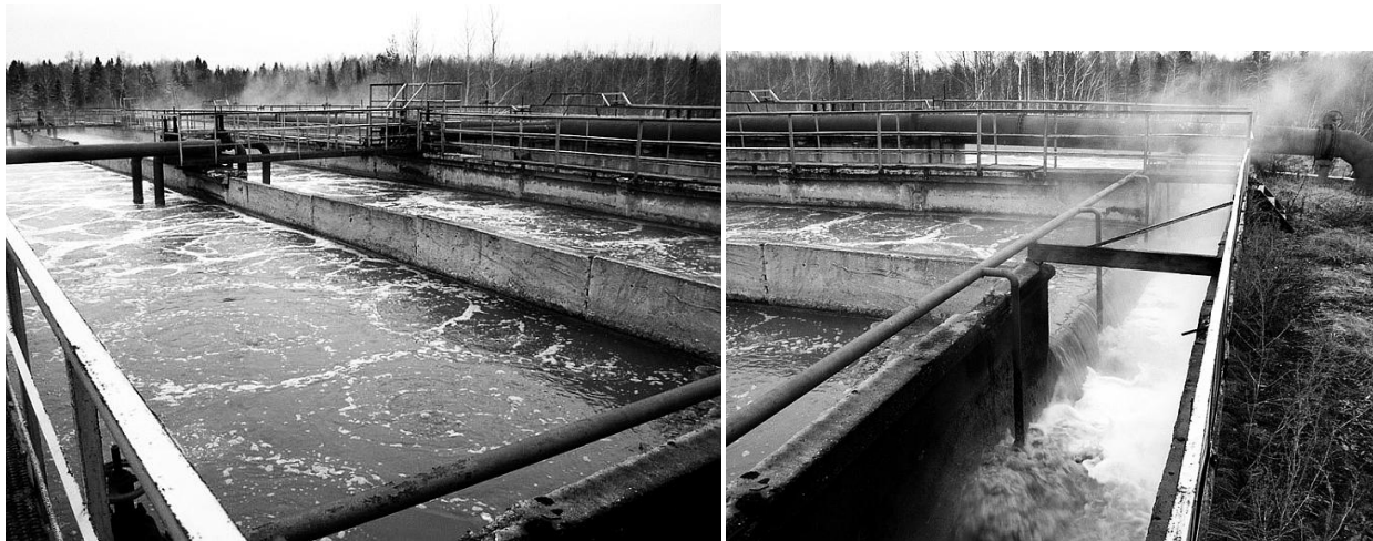
Рис. 34 – Преаэратор-усреднитель
