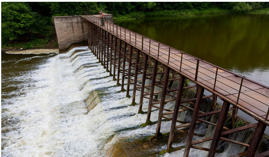
Рис. 6. Плотина. Московская область
