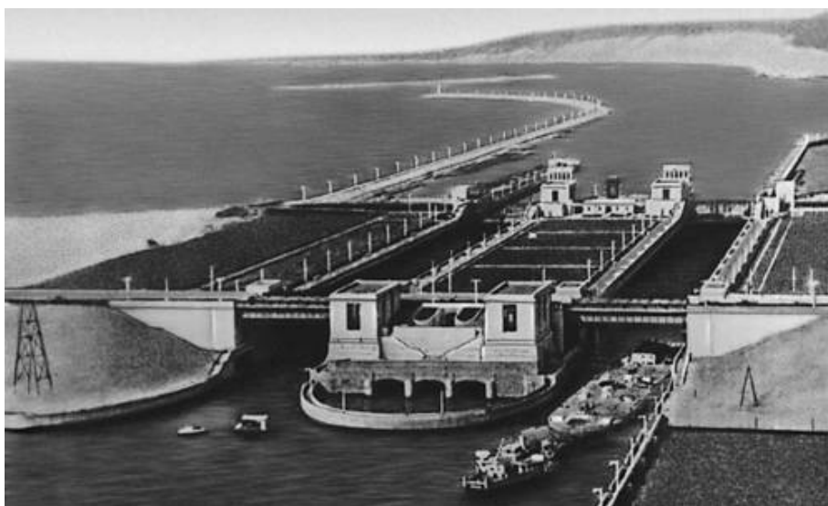
Рис. 3. Куйбышевское водохранилище на участке судоходного шлюза
