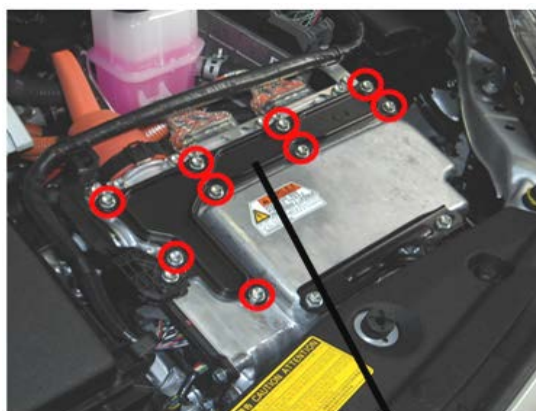
Крышка присоединительных клемм инвертора
