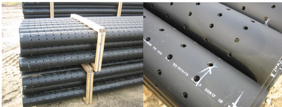
Рис. 14. Складирование и подготовка перфорированных дренажных труб перед укладкой
