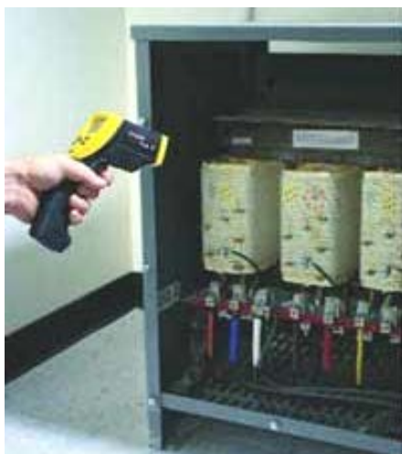
Рис. 2.72. Поиск неисправности обмотки и контактных соединений
